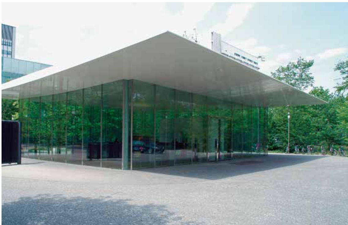
Budova recepce velké průmyslové společnosti. Toto optické spojení interiéru a exteriéru je pro ptáky extrémně nebezpečné. Stejně nebezpečné jsou budovy u vodních nebo zelených ploch, kde odrazivé fasády splyvají s okolím.
