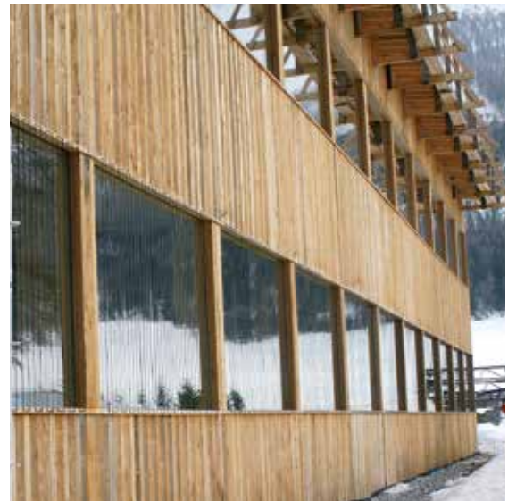
Dobré a levné řešení: vertikálně napnutá nylonová vlákna
