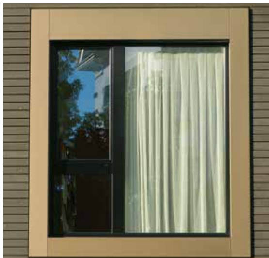
Světlé závěsy zavěšené blízko okna snižují odrazivost: rozdíl je více než zjevný
