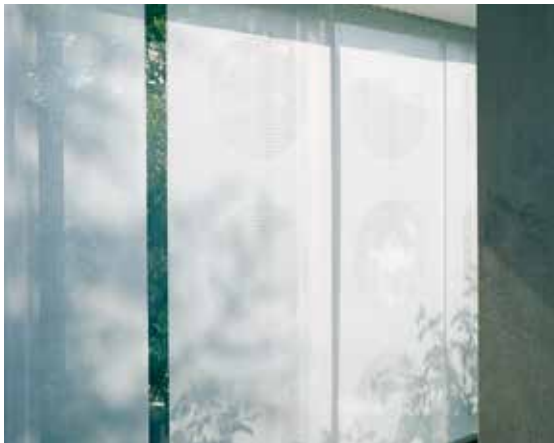
Průhledné ploché žaluzie jsou účinnější než závěsy, neboť jsou vždy zatažené. Fungují však pouze u skla s nízkým indexem odrazivosti.
