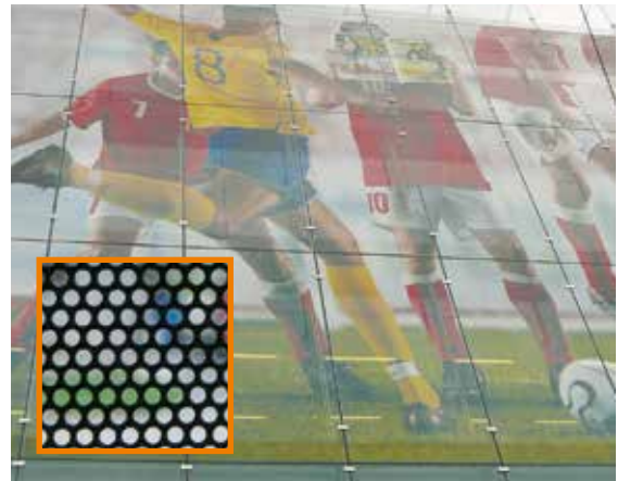
Velkoplošné potisky lze použít k zakrytí celých fasád efektivní reklamou. Většina takových potisků je perforovaná, a umožňuje tak výhled ven.
