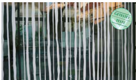
Lineární vzorce jsou osvědčenou prevencí kolizí, křišťálově zbarvená fólie dobře kontrastuje s většinou pozadí
