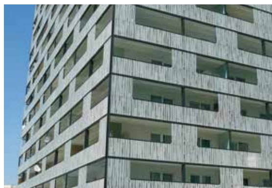
Tištěný vzor zaručuje soukromí uživatelům terasy a zároveň obohacuje 3D strukturu budovy
