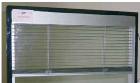
Vestavěné žaluzie poskytují určitý stupeň ochrany i při nastavení pod úhlem
