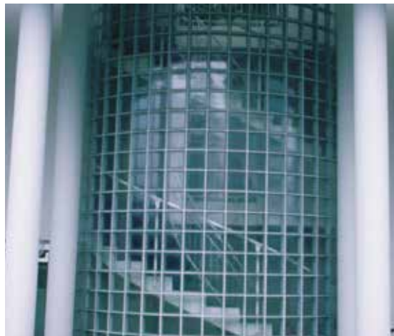
Skleněné tvárnice jsou řešením velmi bezpečným pro ptáky a z hlediska jejich ochrany je lze použít bez omezení
