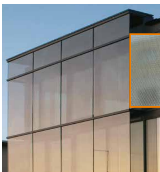
Jemné textilie laminované do skla snižují venkovní odrazivost, slouží jako ochrana proti oslnění v interiéru, a přitom nadále umožňují výhled ven (vnitřní textilie je černá)
