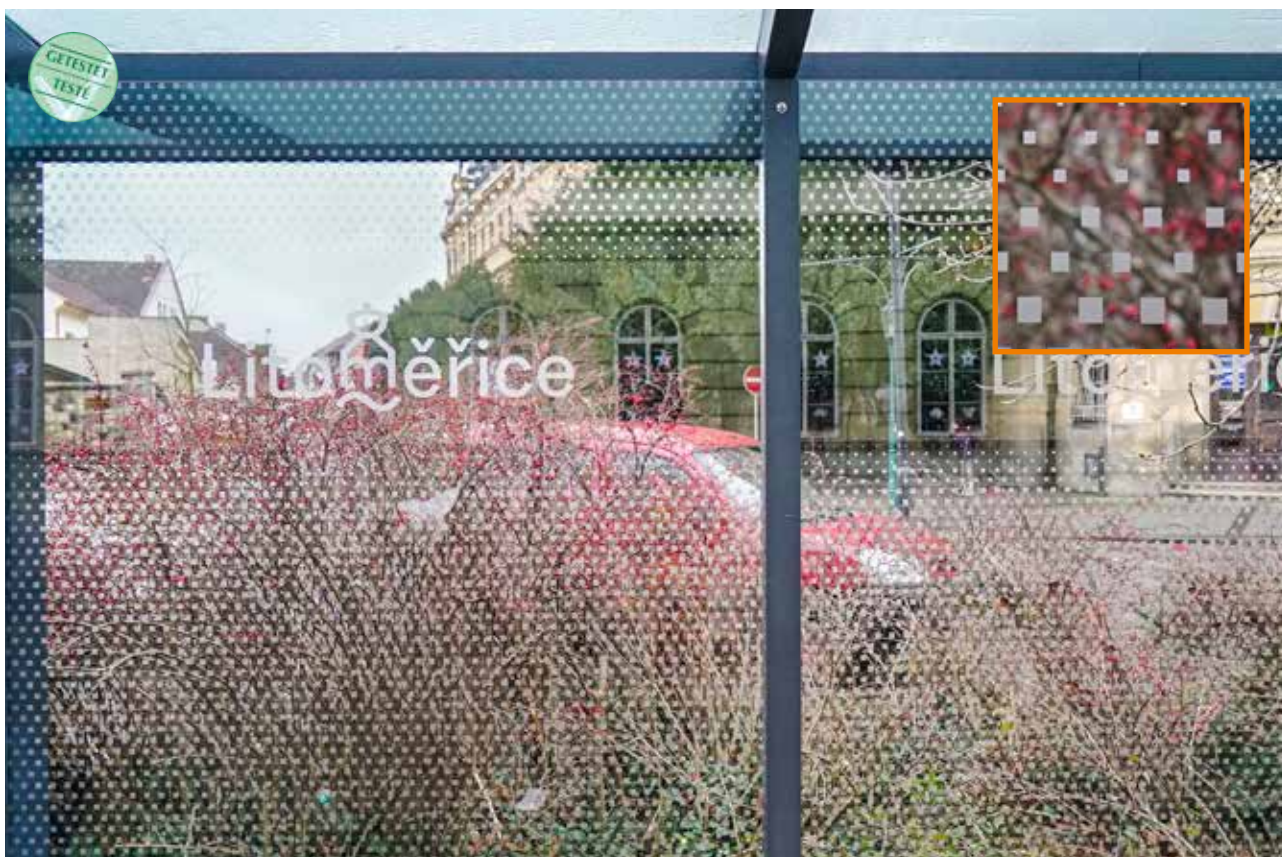
Použití loga města v rámci zviditelnění zastávky je dalším možným řešením. Zbytek plochy je zviditelněn malými čtverečky.
