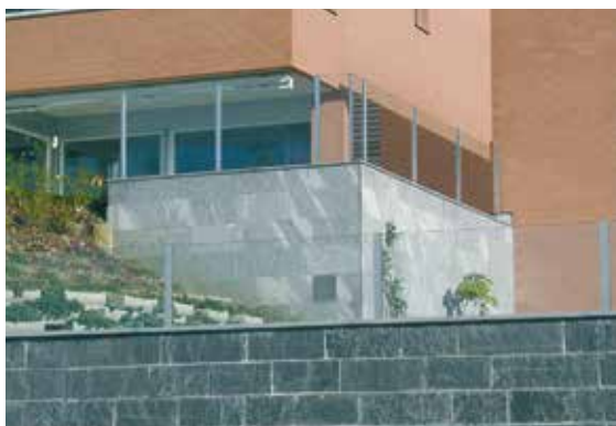
Prosklené balkonové stěny a protihlukové stěny
