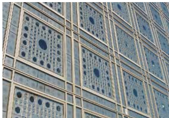
Fasáda na budově Institut du Monde Arabe dodává Paříži orientální nádech
