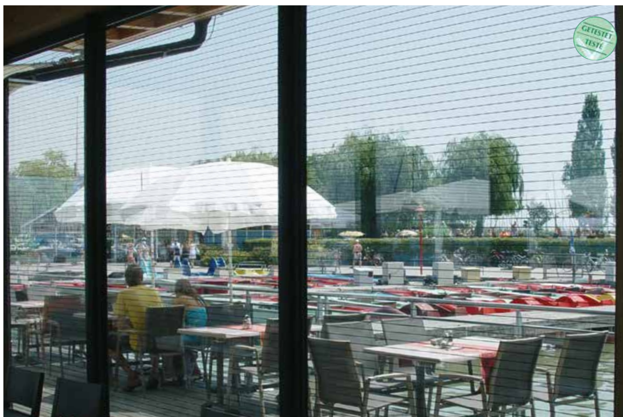
Tenké linie jsou bezpečné pro ptáky a nijak nezakrývají výhled z restaurace. Vzor navíc zajišťuje, že hosté restaurace budou ušetřeni pohledu na uhynulé ptáky.
