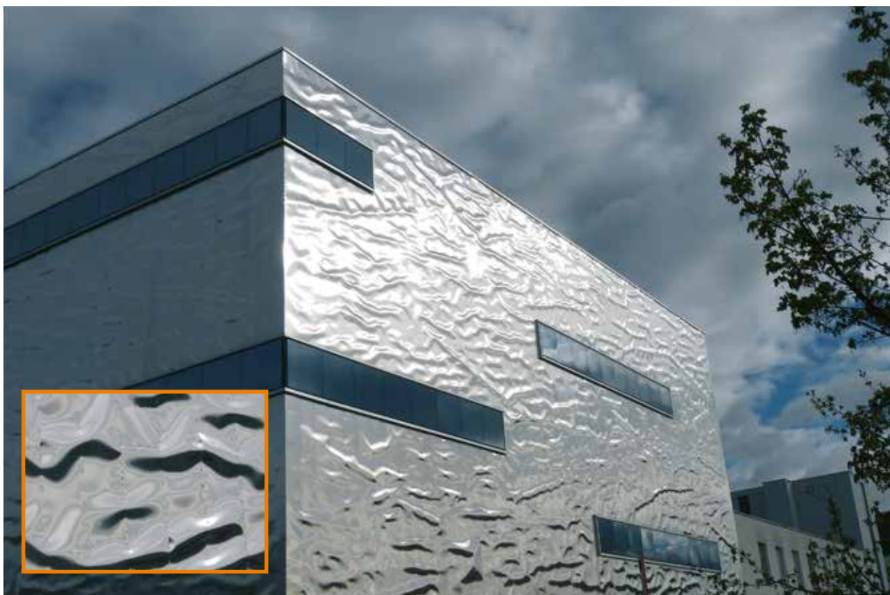
Přestože je tato budova skladu téměř celá pokrytá reflexním kovem, je díky jeho intenzivní deformaci pro ptáky neškodná
