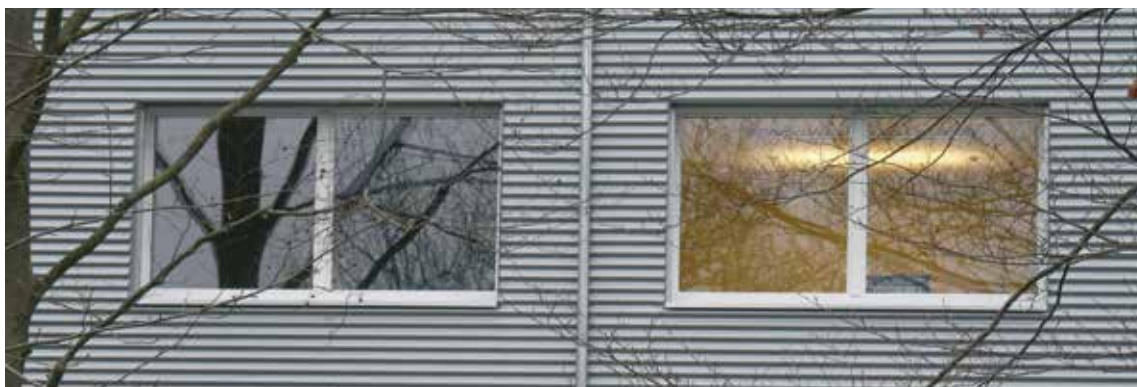
Odrzivost závisí na řadě faktorů, například na osvětlení vnitřního prostoru za oknem. Stejně sklo vytváří tím silnější odrzy, čím tmavší je pozadí za ním.
