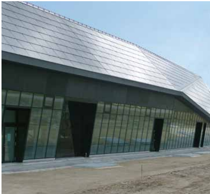
Tato osobitá hala má solární střechu, která rovněž tvoří součást fasády. Okna pod úhlem odrážejí zem, to však ptákům bezpečí nezajistí...
