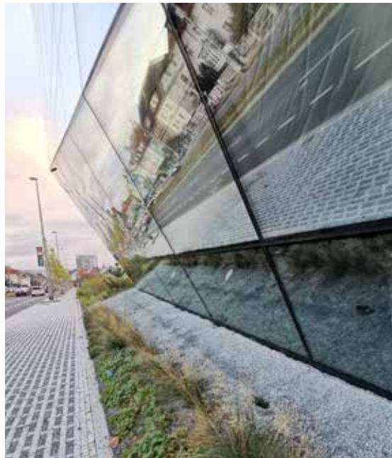
... jak dokládá i ptačí mrtvolka pod touto šikmou, ale silně zrcadlicí fasádou
