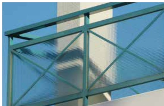
Poloprůhledné zasklení balkonu, zde vyrobené z lisovaného skla, nepředstavuje pro ptáky žádné nebezpečí
