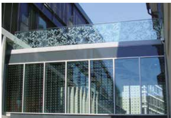
Pěší viadukt se dvěma různými, ale v obou případech účinnými řešeními
