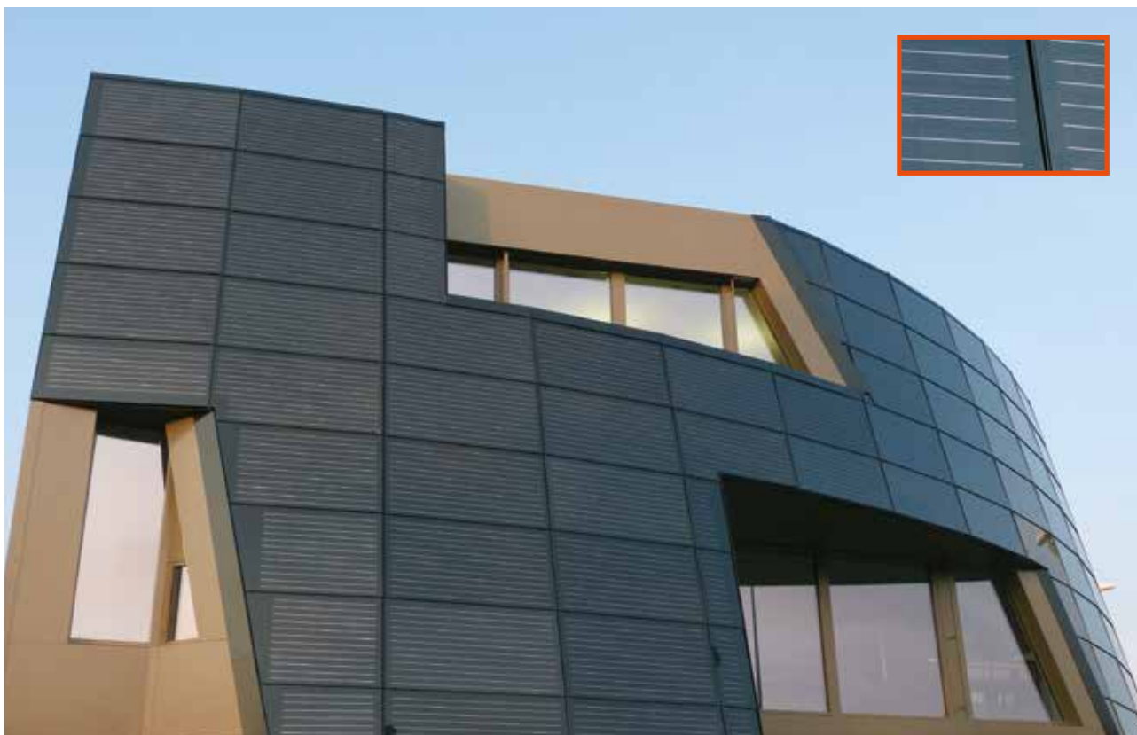
Inovativní architektura se solárními panely na fasádě. Tyto solární panely jsou sice reflexní, ale zabudované čáry zajišťují dostatečný rozptyl, a panely tak nejsou ptákům nebezpečné.
