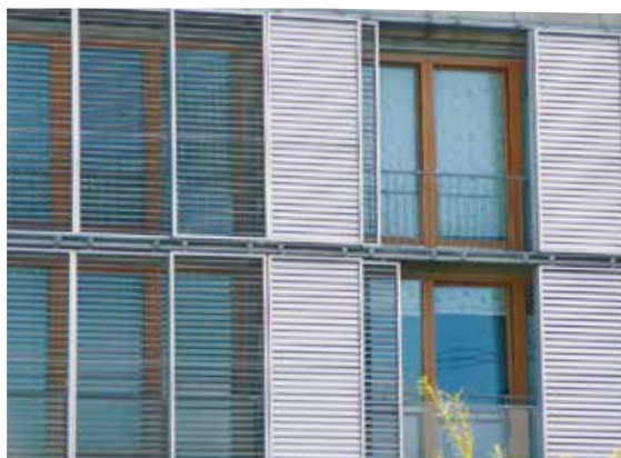
Tyto vodorovně posuvné clony chrání před horkem a zároveň před kolizemi ptáků
