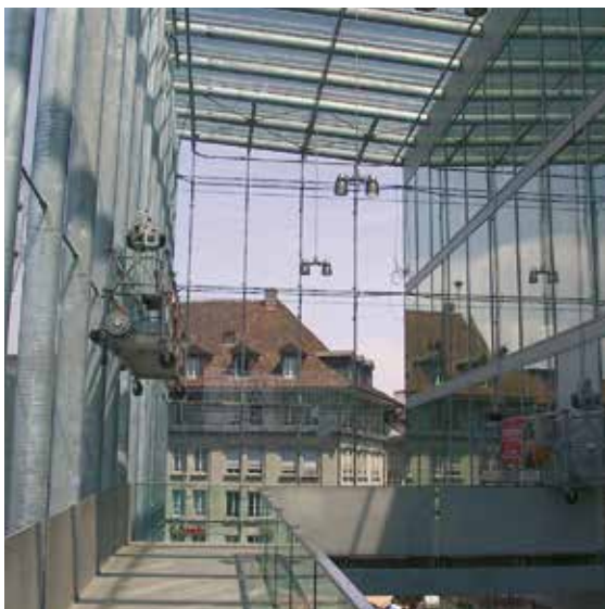
Prosklená nástavba nádražní budovy
