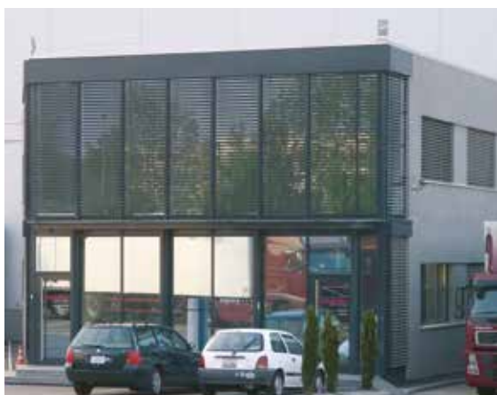
Protisluneční sklo v budově recepce: žaluzie v horním patře výrazně snižují odrazivost skla
